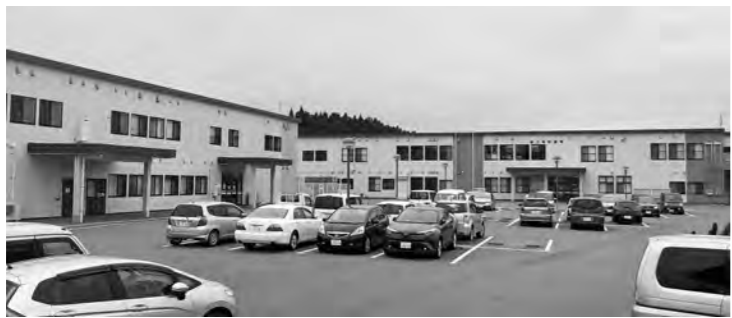
解体される第2・第3庁舎
