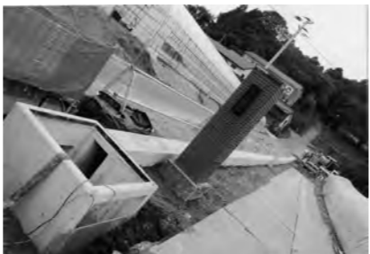
工事が進む入谷公民館進入道路
