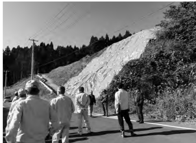
▼歌津峰畑団地の法面
