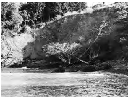
戸倉地区の崩落現場
