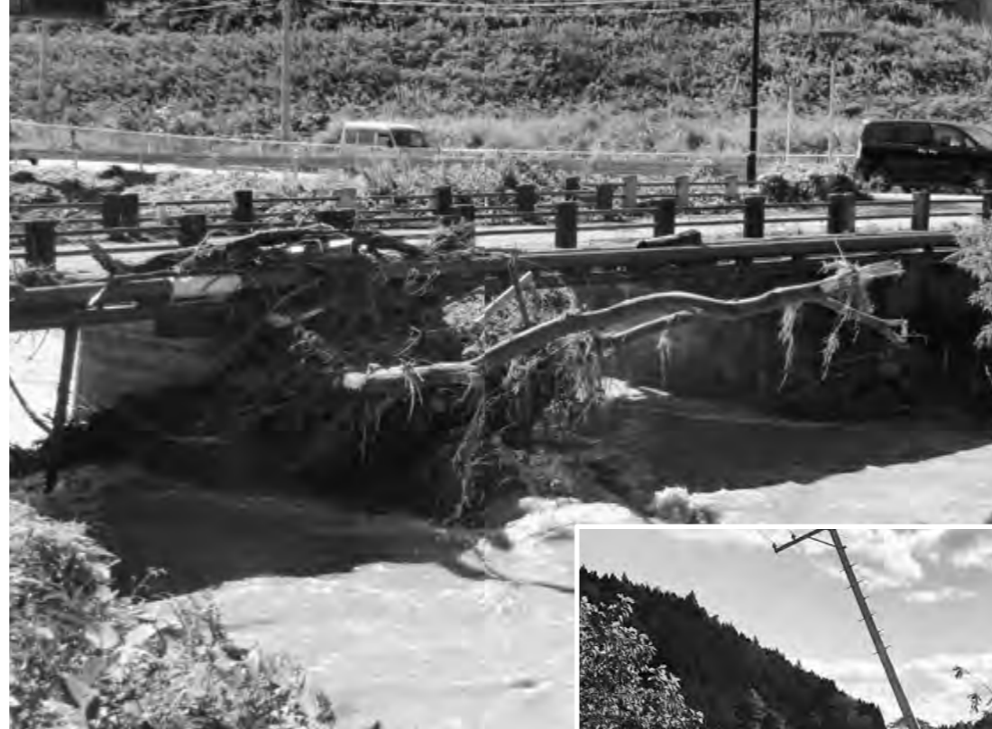
志津川小森地区の熊田橋
