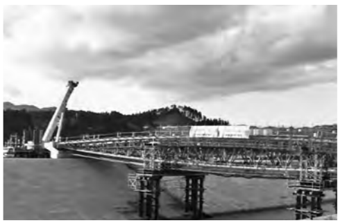
完成間近の中橋
