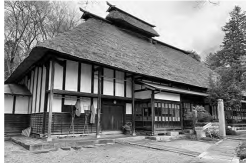
▲【ひごろの里、松笠屋敷屋根等改築工事】 4,400万円
