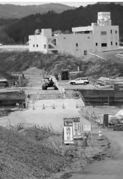
高野会館と解体が進む港橋
