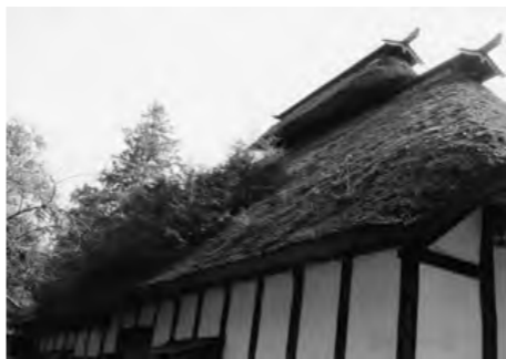
修繕工事を待つ松笠屋敷の屋根
