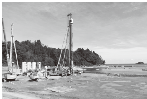
やっと始まった防潮堤工事
