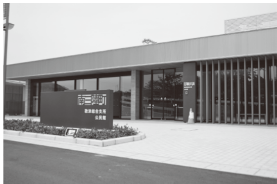
歌津総合支所
