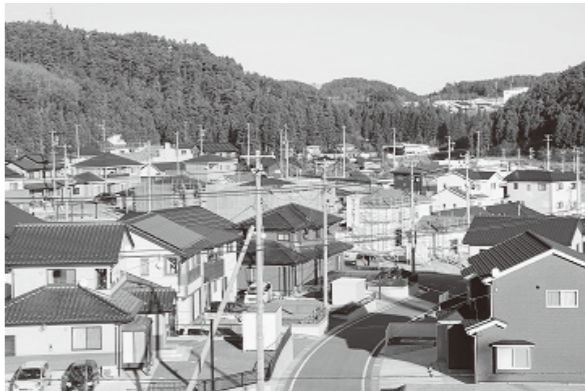
志津川地区の中央団地の住宅再建
