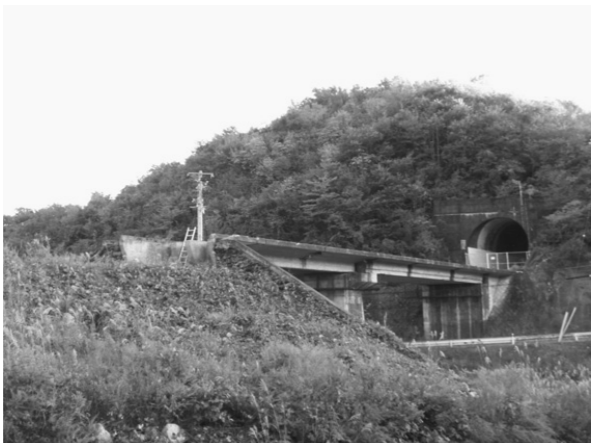
寸断されたままの線路
