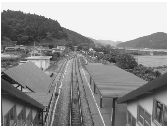
列車の走らない線路
