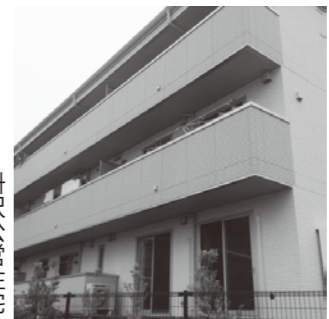
枳沢公営住宅
