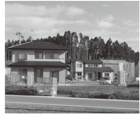
建築が進む防集団地
