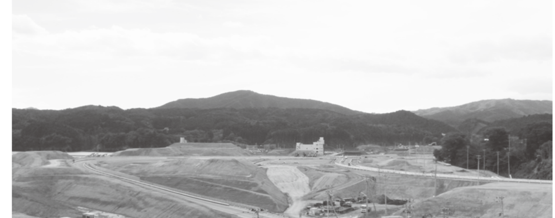
造成が進む志津川「まちびらき」エリア
