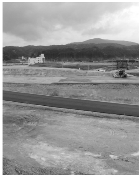
造成中の先行エリア
