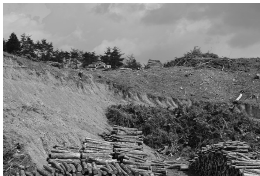
造成の進む志津川東団地
