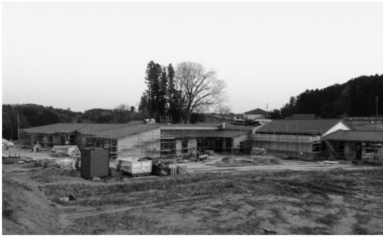
建設中の老人ホーム
