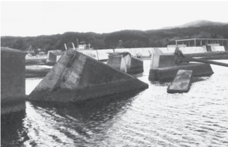
破壊された本浜防潮堤
