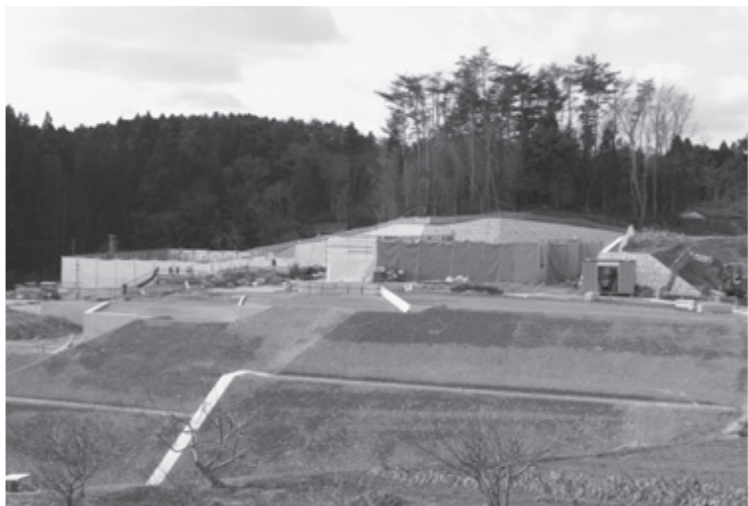
基礎工事中の名足災害公営住宅
