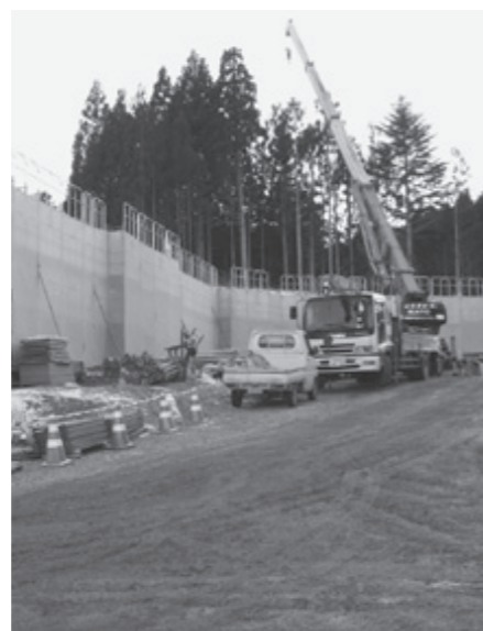
建設が進む桜沢災害公営住宅
