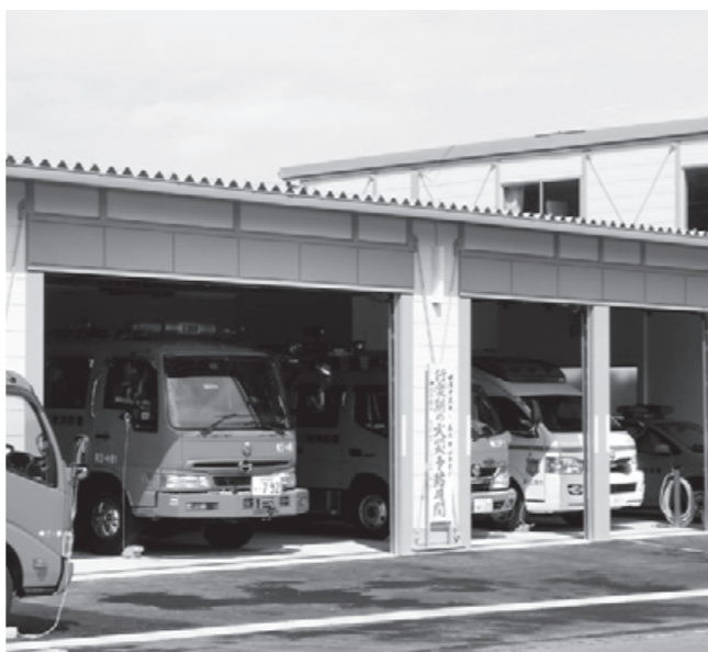
▲ 移転後の消防署
