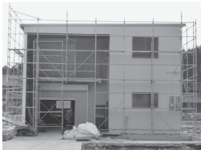
▲建設中の仮設工場(歌津地区)
