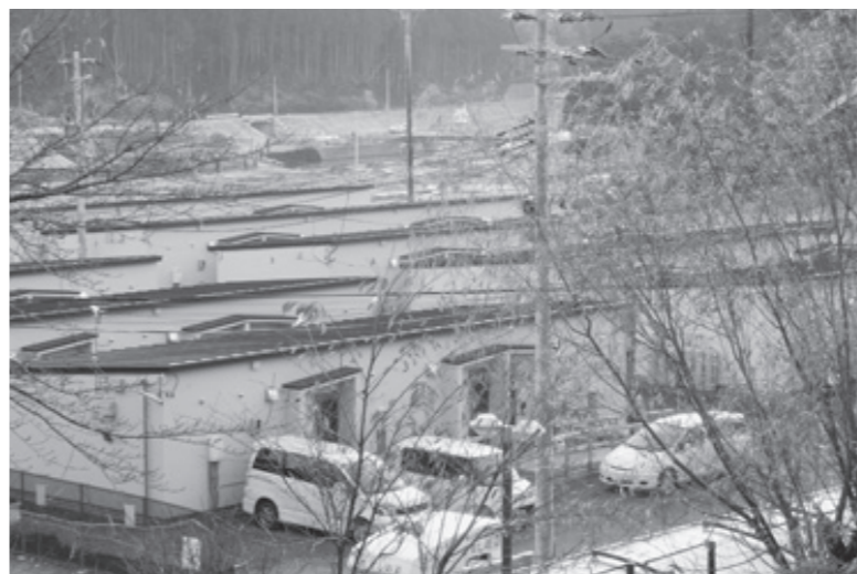
▲伊里前小学校仮設住宅
