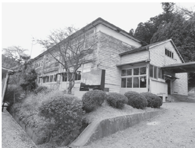
▲解体が予定されている旧入谷中学校
