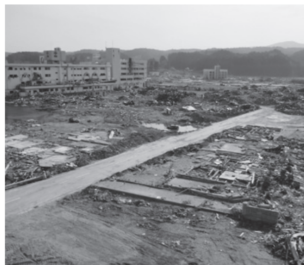
▲志津川地区のガレキ撤去進む
