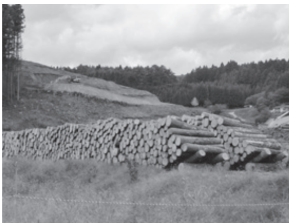
▲小森地区の三陸道開通へ樹木の伐採進む
