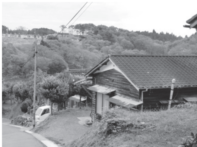
▲柞沢住宅から平成の森仮設を望む
