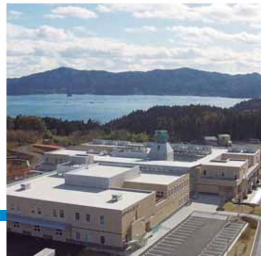
病院・総合ケアセンター上空（志津川湾を望む）
