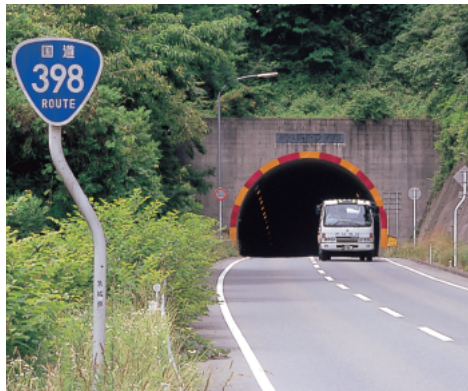
新水界トンネル付近の国道398号——甚之丞が行った水界道路整備は、明治の新道開削から現在の国道整備へと受け継がれていった
