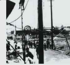
大火後の作業
