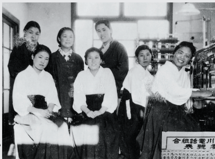
一部業務が始まった志津川郵便局 電話交換室（大正8年頃）
