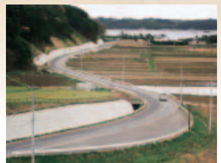
町道白松線拡幅改良工事完成(平成10年)
