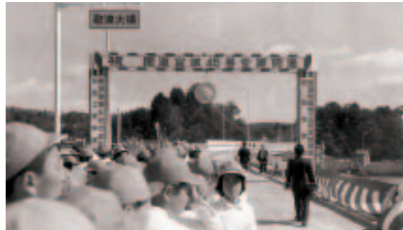
歌津大橋開通(昭和47年)
