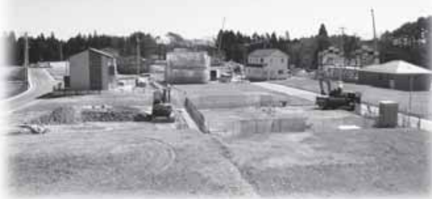
●造成工事が完了し、住宅の建築が進む団地
