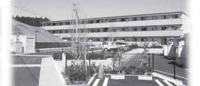
●建築工事が完了し、入居が進んだ復興住宅
