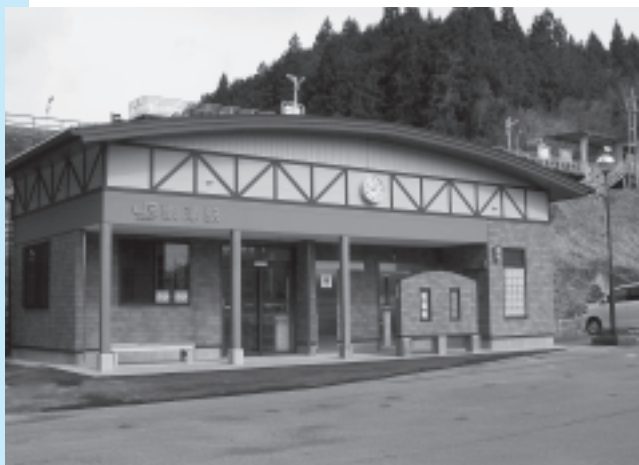
▲JR歌津駅乗車券発売所・公衆トイレ整備
