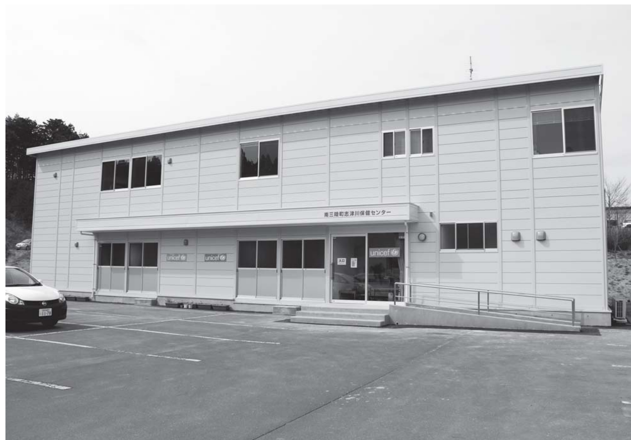
志津川保健センター
