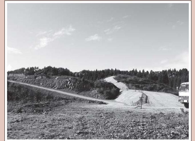
【港地区】長羽団地
