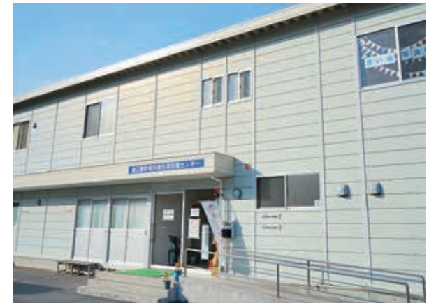
ユニセフから寄贈された旧志津川保健センター
