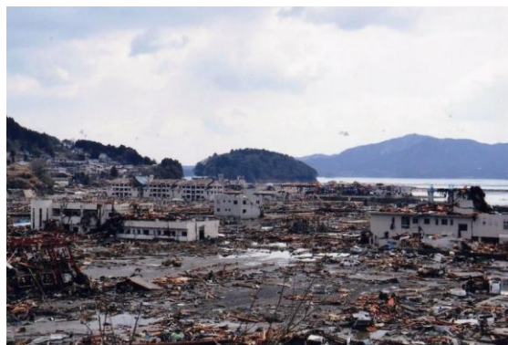
〔平成23年3月12日 志津川地区中心部〕
