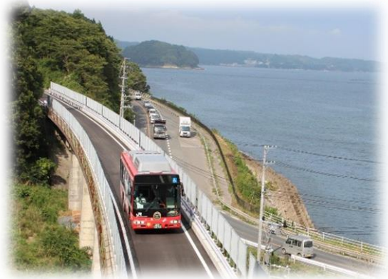
JR 気仙沼線（BRT 専用軌道部分）
