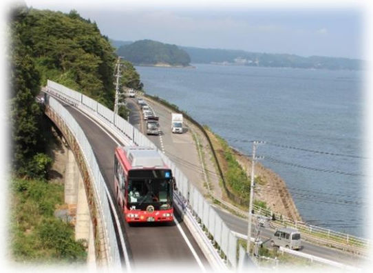
JR 気仙沼線（BRT専用軌道部分）
