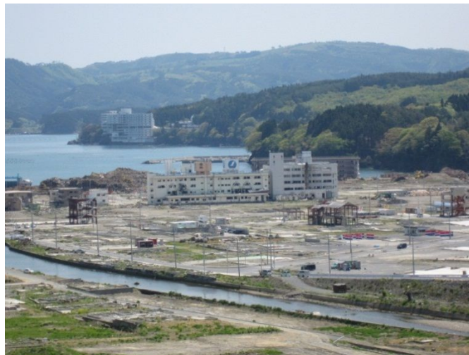
志津川中学校より志津川市街地を望む(平成24年5月撮影)
