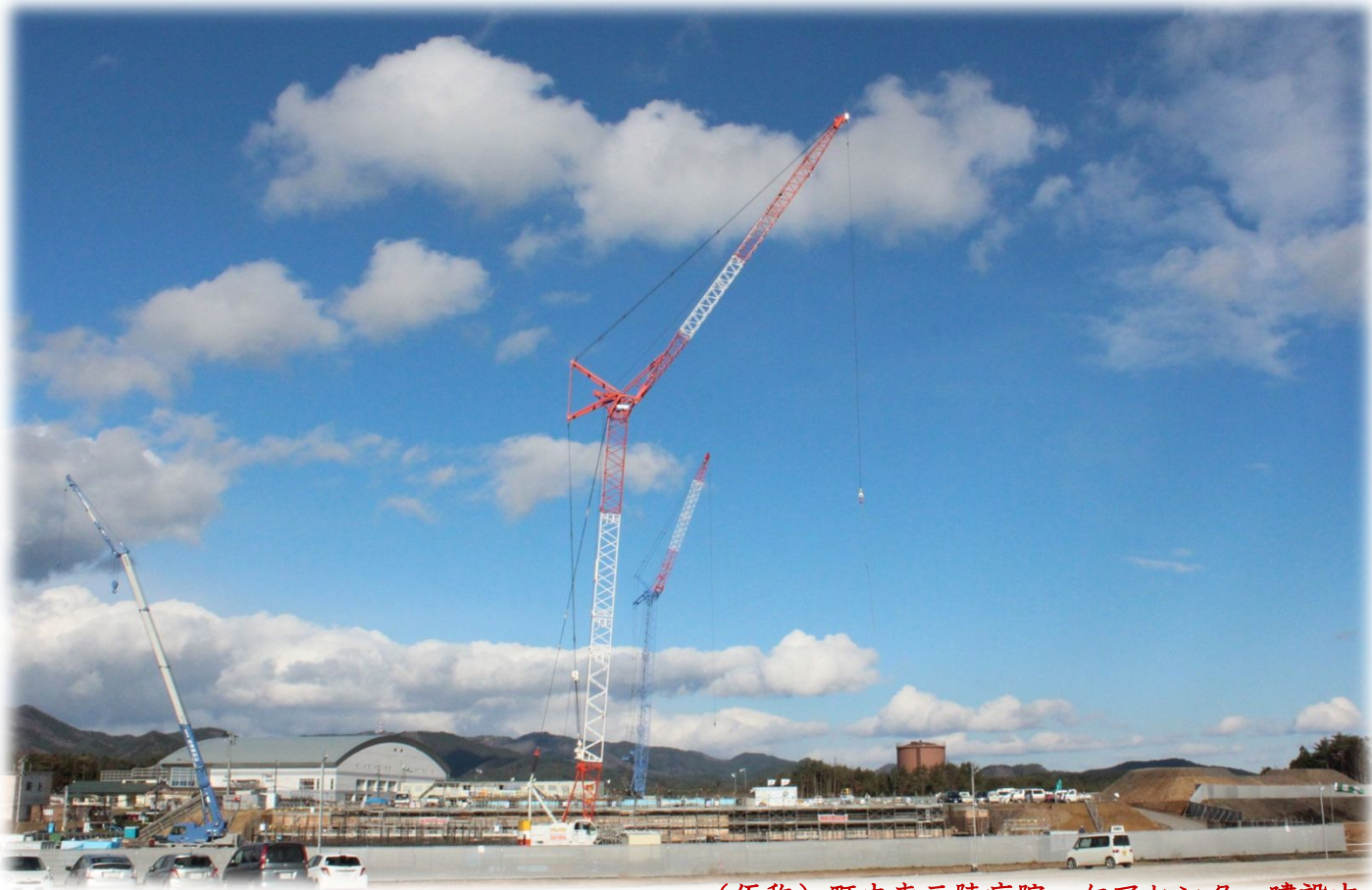
(仮称) 町立南三陸病院・ケアセンター建設中 【平成26年12月5日撮影】
