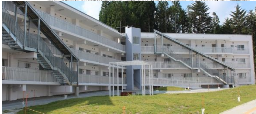
町営入谷復興住宅
