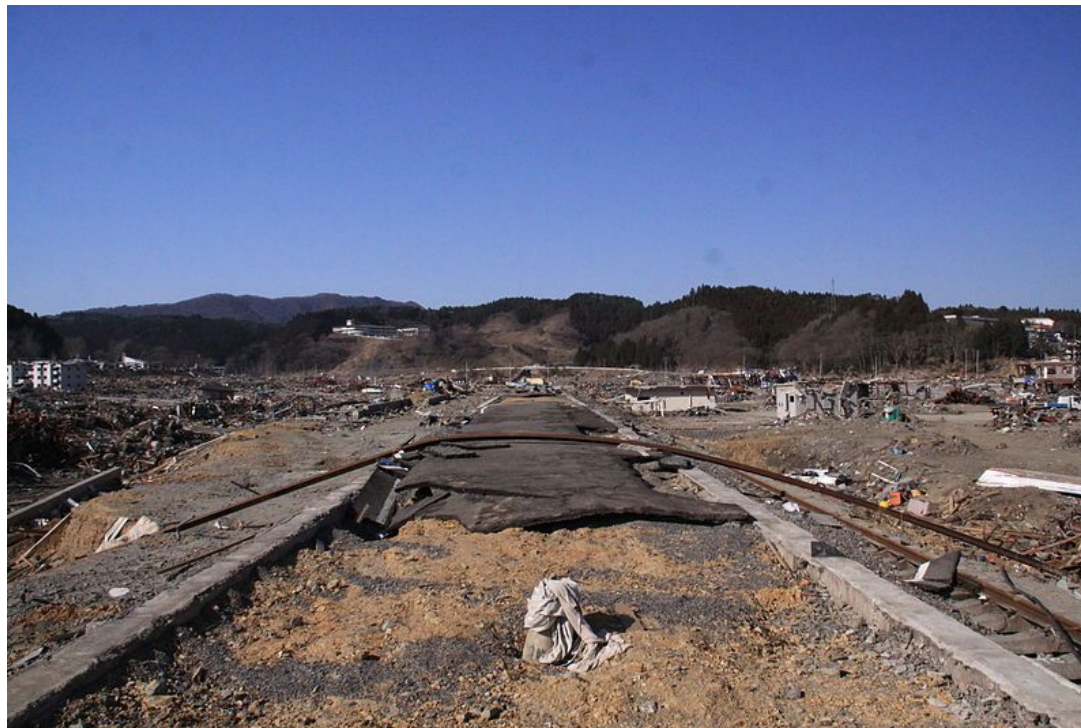
志津川駅のプラットホーム ホーム上を横切るのは津波に 捻じ曲げられたレール。
