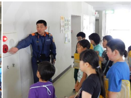
消火栓の扉を開けると、15mのホースが2本入っていました。
