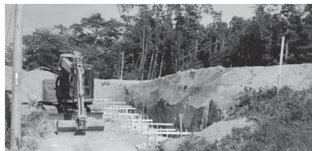
▶復興に向け建設が進むアーリーナ付近
