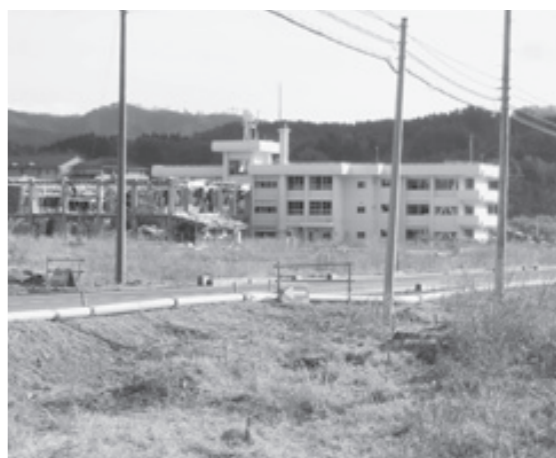
▲被災した戸倉小学校
