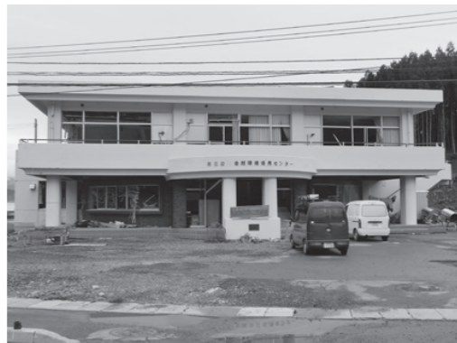
被災した自然活用センター
