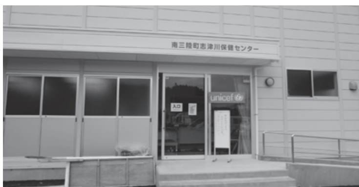
▲ 志津川保健センター
