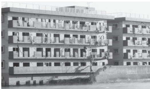
被災した松原住宅
