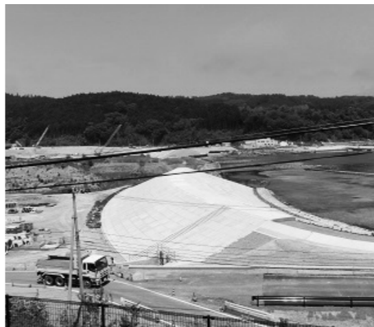
戸倉公民館2階から防潮堤と折立地区を望む
