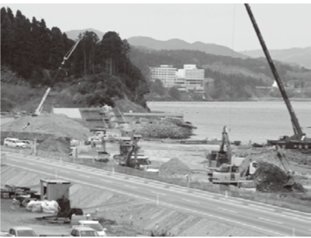
防潮堤工事が急ピッチで進む
