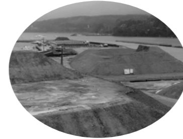
被災した低地部
