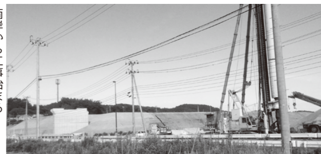
両岸から工事始まる
