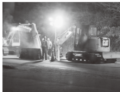
水道管の夜間工事
