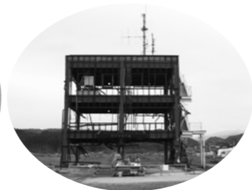
防災対策庁舎
