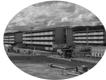
建設が進む新しい住居
