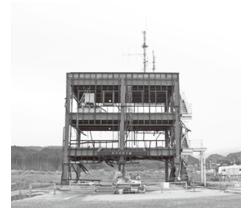
防災対策庁舎
