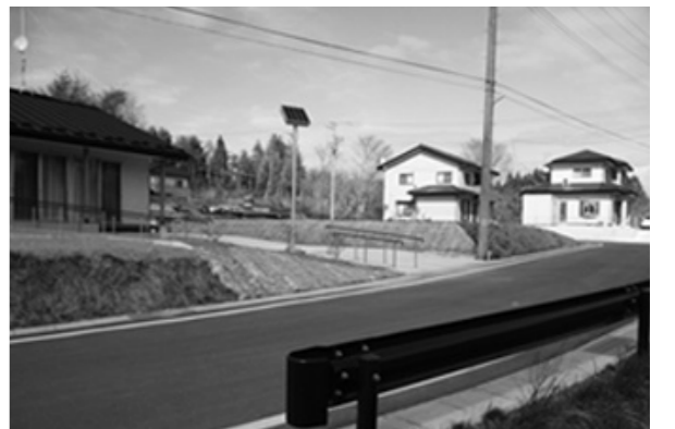
完成した藤浜団地
