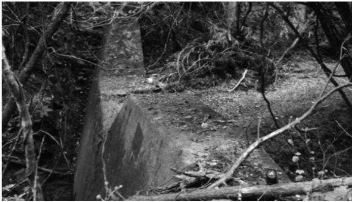
土砂で埋まった砂防ダム
