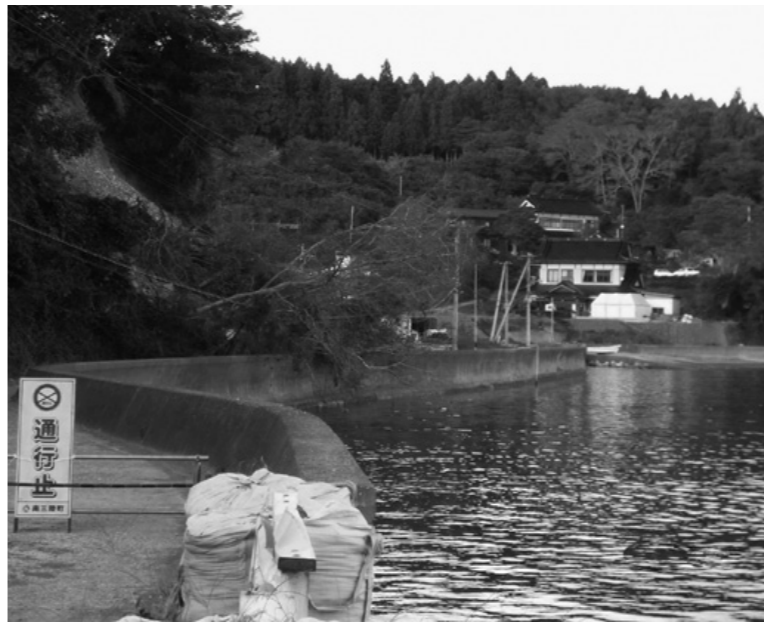
寄木線の崩落現場
