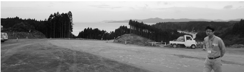
急がれる造成工事
