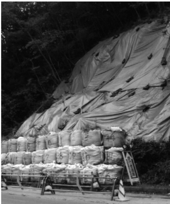
土砂崩れ現場
