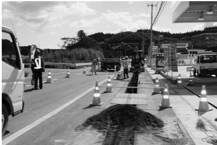
水道管の老朽化対策
