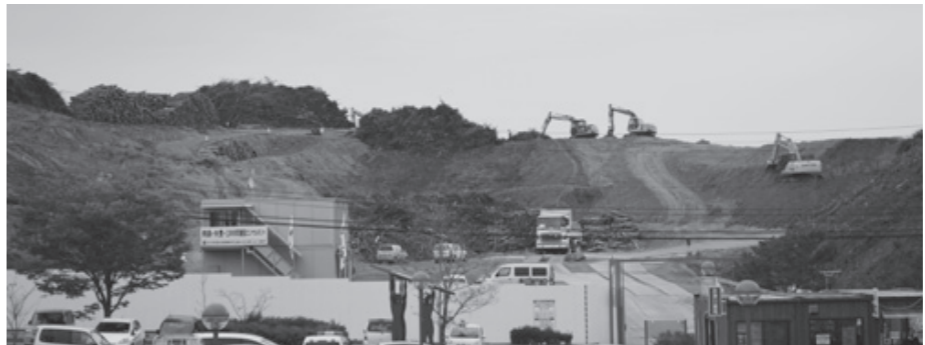
志津川地区の東浜造成工事
