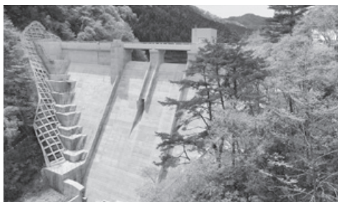
▲5月に完成した歌津地区弘川ダム
