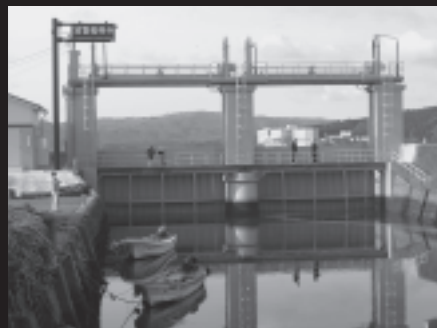
耐震化・閉鎖速度改良工事を終えた水門 (新井田川)
