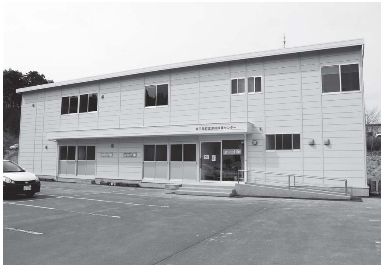
志津川保健センター
