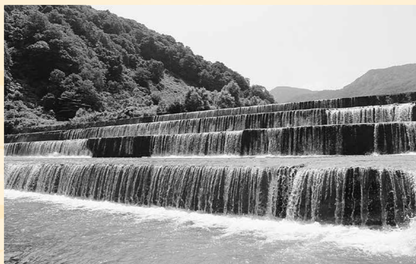
瀬場砂防堰堤
